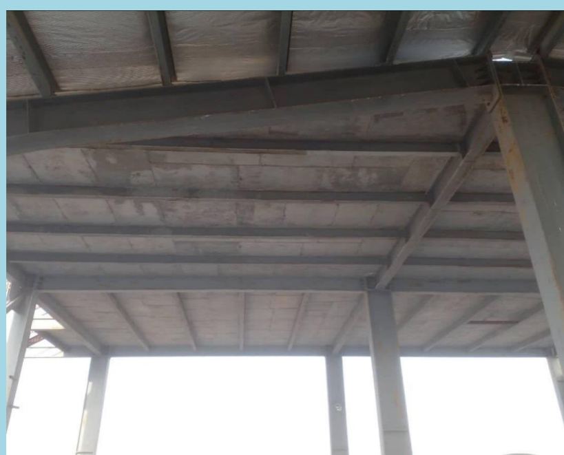
شکل ۴ خیز بوجود آمده در تیر آهن ها
